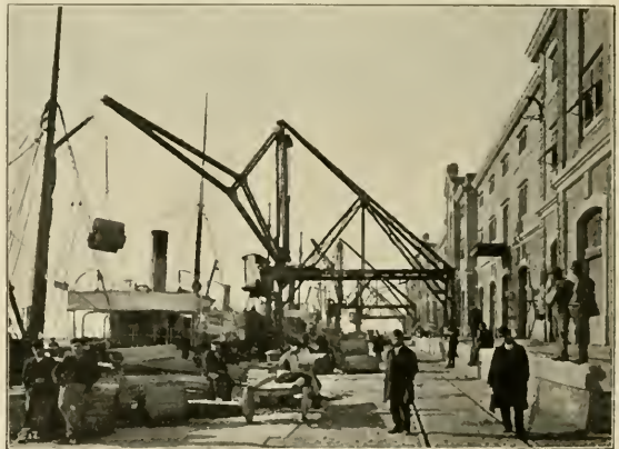
Abb. 225. Hydraulische Fahrkrane auf den Molos in Triest.
